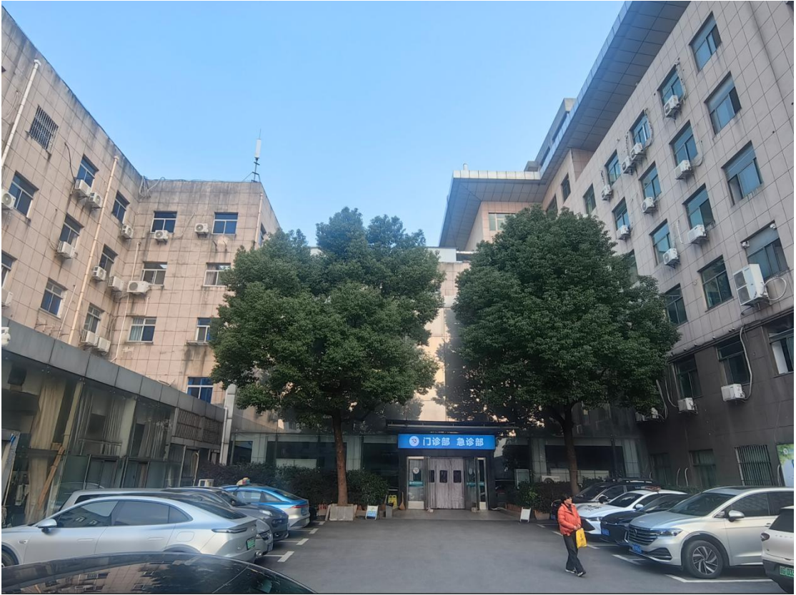
图 28 一号楼分体式空调
