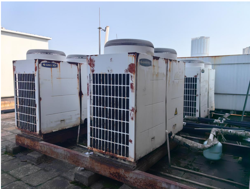
图 18 楼顶数码涡旋式多联机
