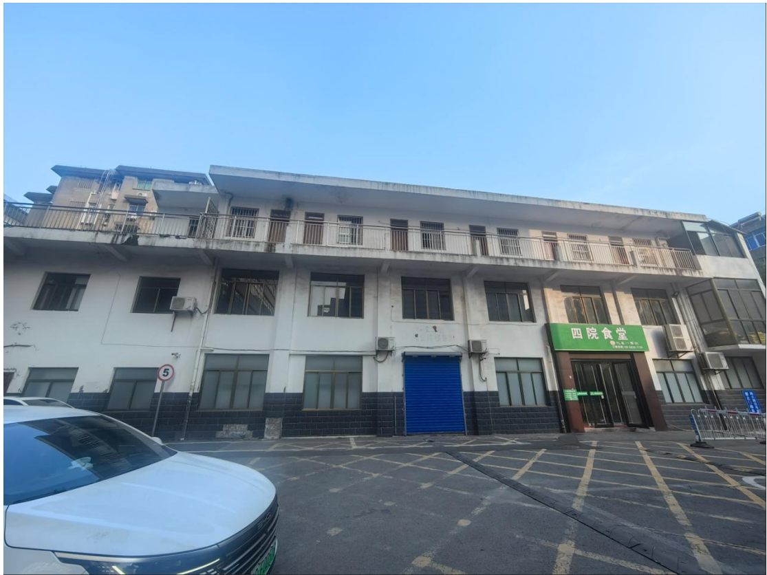
图 33 食堂分体式空调
