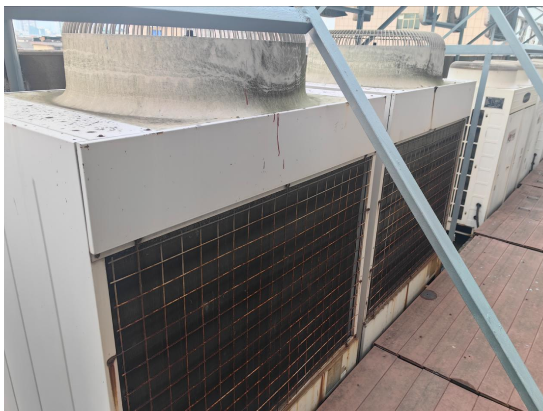
图 21 手术室数码涡旋式多联机
