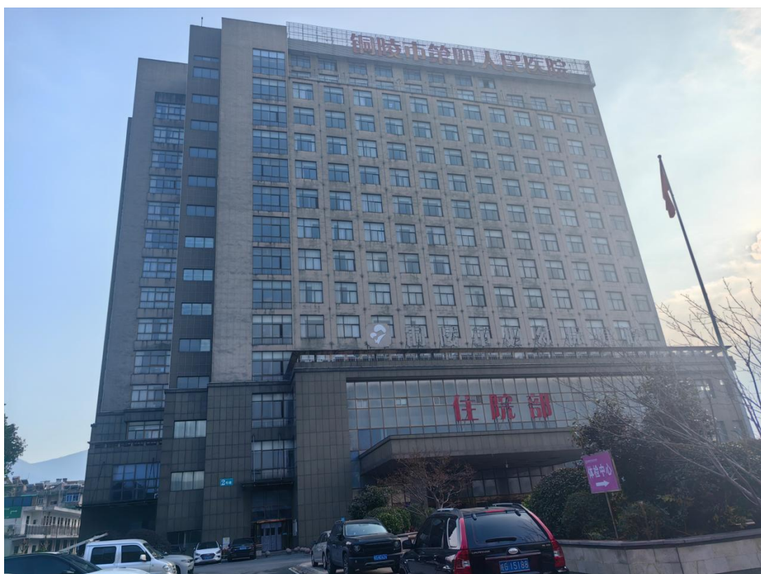
图6 住院部楼（2号楼）
