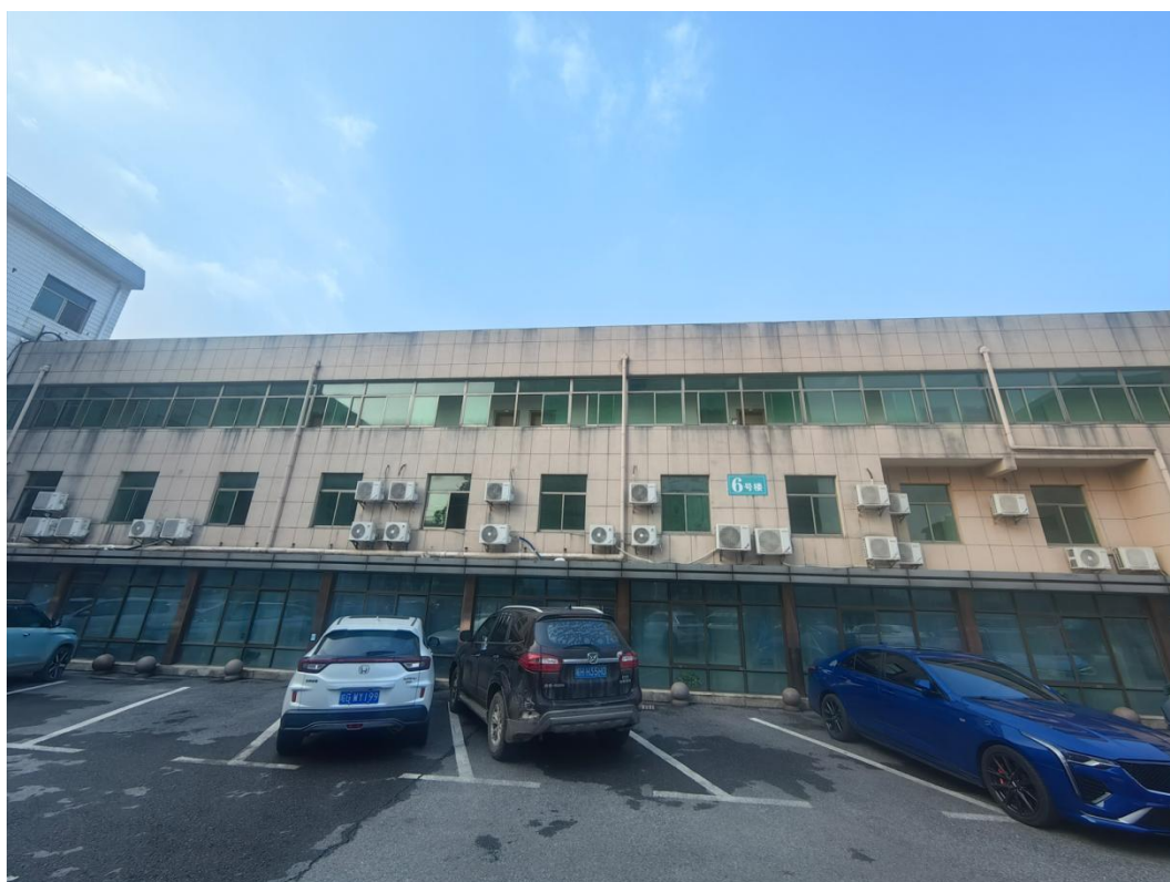
图 32 六号楼分体式空调
