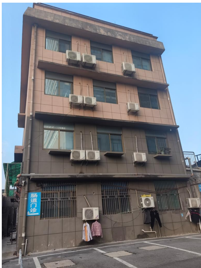
图 31 五号楼分体式空调
