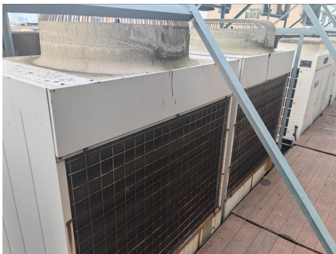
图 21 手术室数码涡旋式多联机
