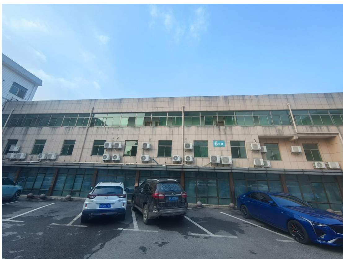
图 10 体检中心（6 号楼）
