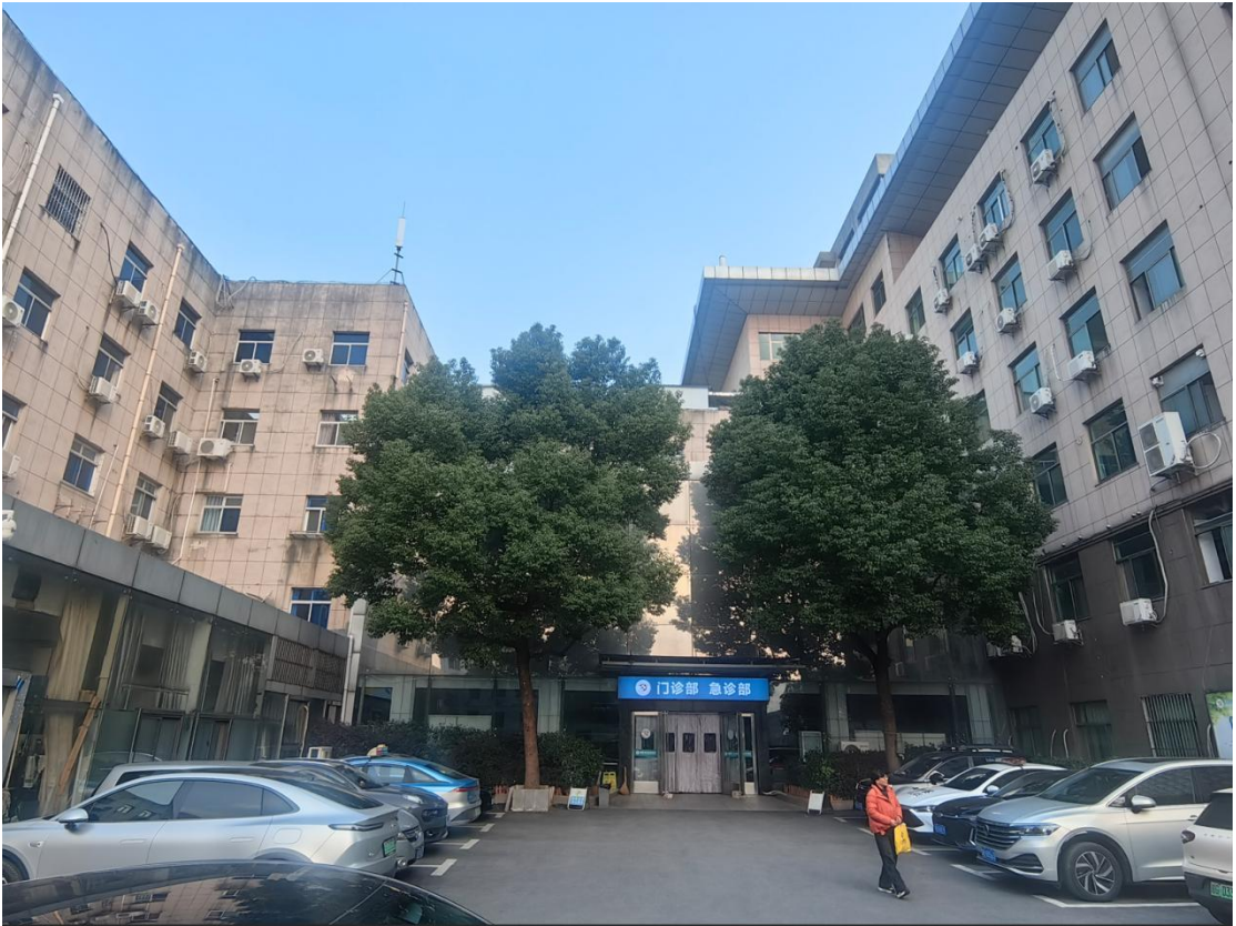
图 28 一号楼分体式空调
