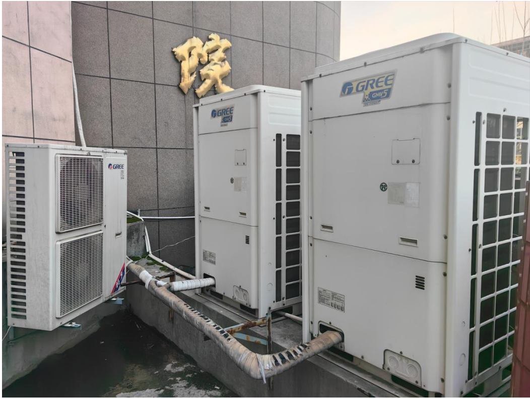
图 17 一号楼变频多联式空调室外机
