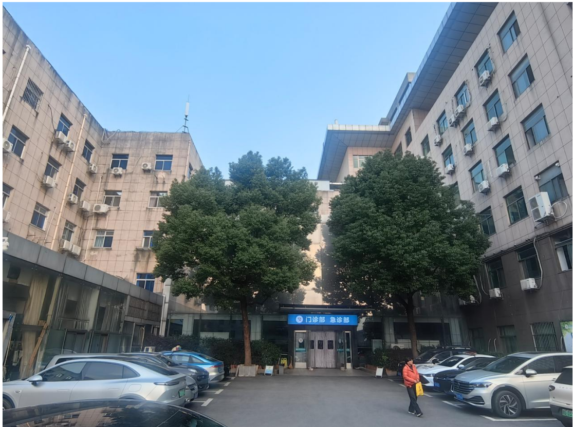
图 5 门诊、急诊楼（1号楼）
