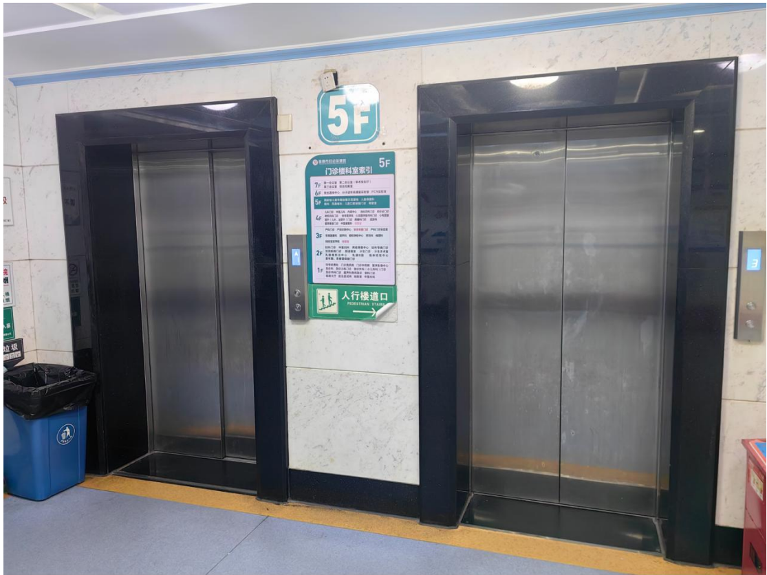
图 45 电梯间实景图
