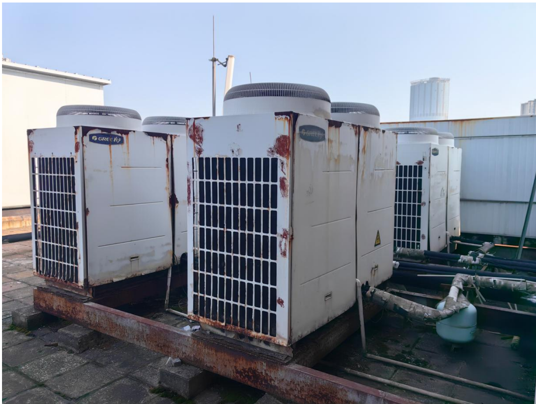
图 18 楼顶数码涡旋式多联机
