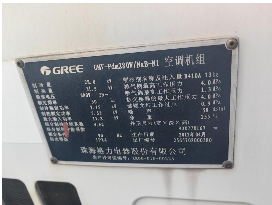
图 20 四层平台室外机铭牌
