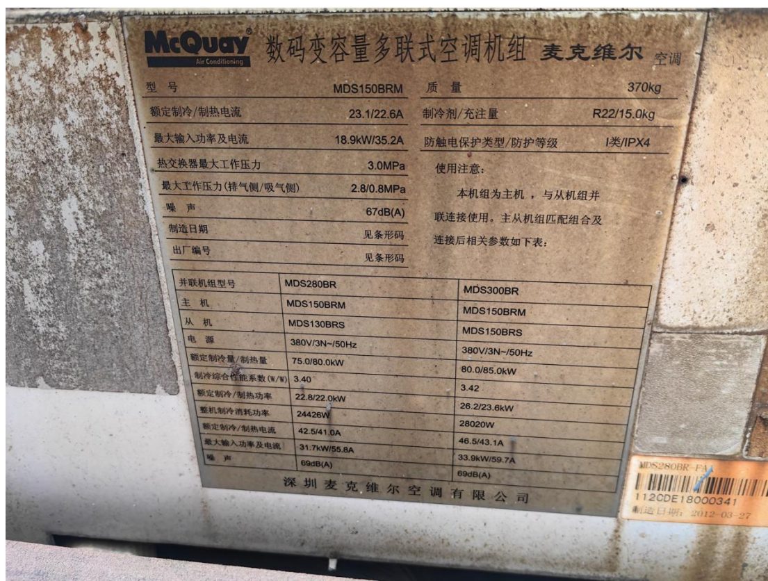
图 22 数码涡旋式多联机铭牌
