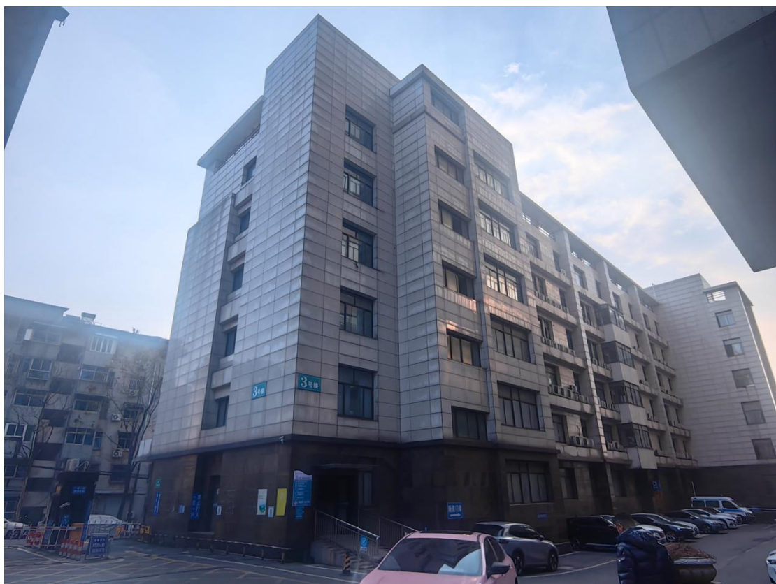
图 29 三号楼分体式空调
