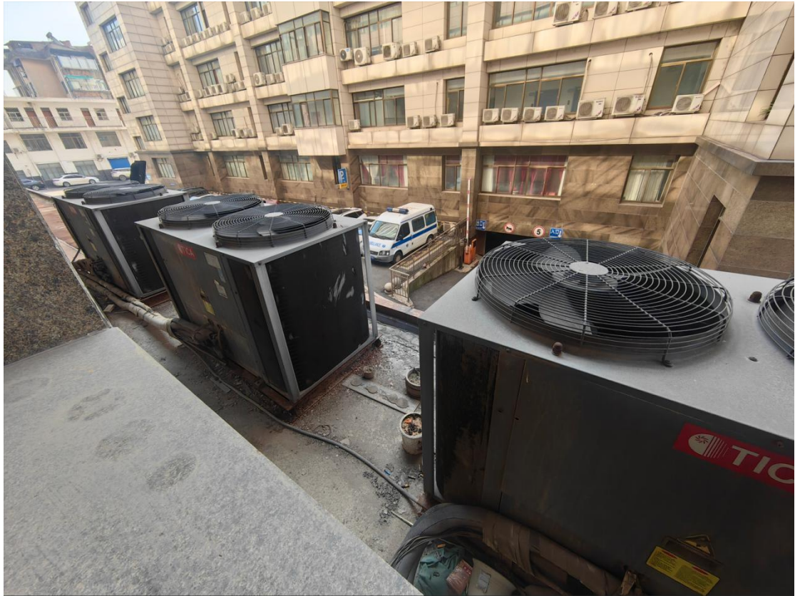
图 25 风冷管道式空调机照片
